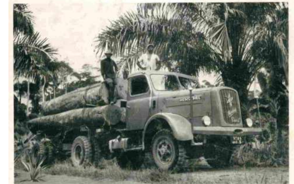
Henschel-Lastwagen HS 140 A, mit Allrad-Antrieb im Urwald von Jaounde, Kamerun, beladen mit 18 t Limba-Holz
