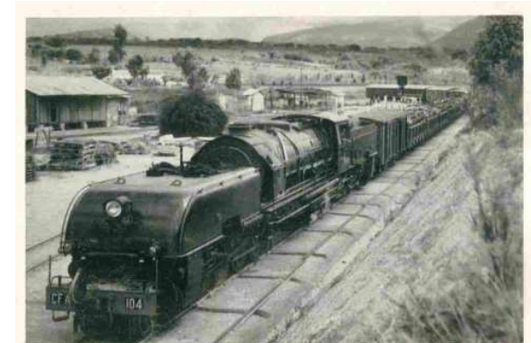
Henschel-Bayer-Garratt-Lokomotive der Moçamedes-Bahn, Angola (Port. West-Afrika) auf der Strecke Villa Avianga nach So da Bandeira
